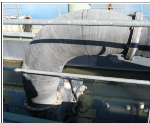
verstärkte Verschleißschicht für stark schleißende Anwendungen
