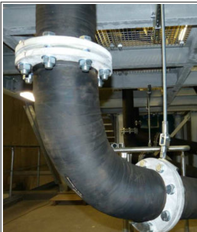
vakuumfester Bogen mit Stahlringen
